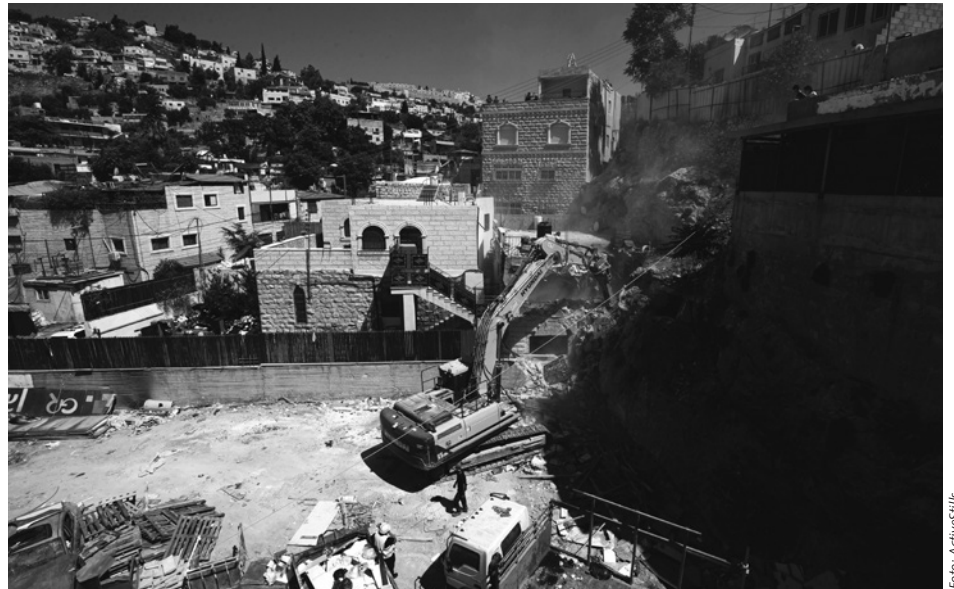
Ein Bulldozer, der ein Gebäude im Jerusalemer Stadtteil Silwan abreißt, 10.08.2021
